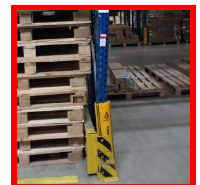
angefahrenes Rahmenprofil
